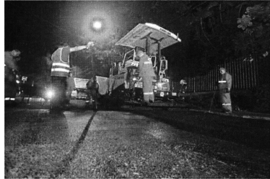
Repavimentación Asfáltica
