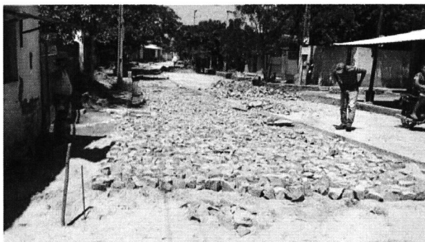
Obras de Desagüe Pluvial
