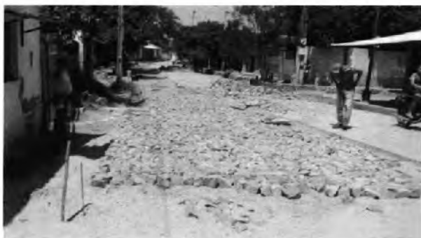
Obras de Desagüe Pluvial
